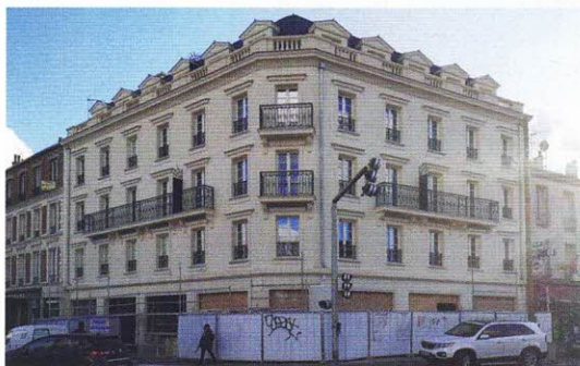
Le bâtiment construit par Loïc Richalet à Romainville.
