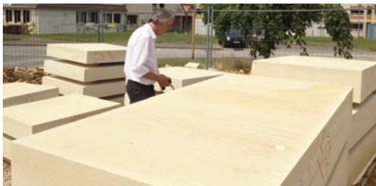
Pascal Delrue au milieu des blocs de pierre de Noyant sur son chantier de logements sociaux à Verdun.
