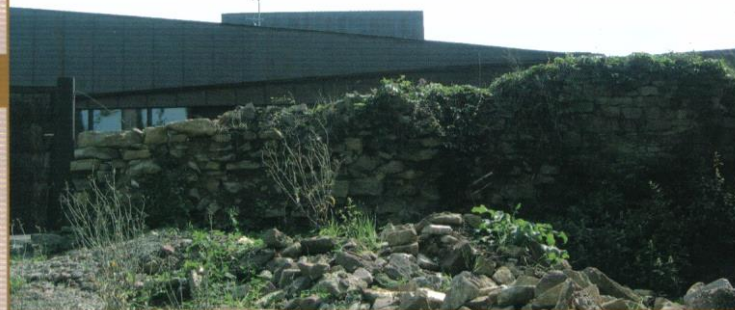
le Mur blanc avant restauration.
